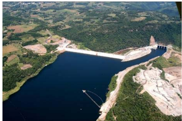
Situação atual (mai/2006)
