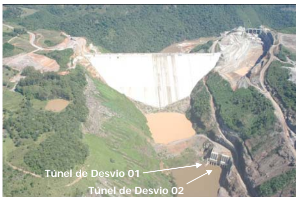
Situação no início do enchimento (out/2005)
